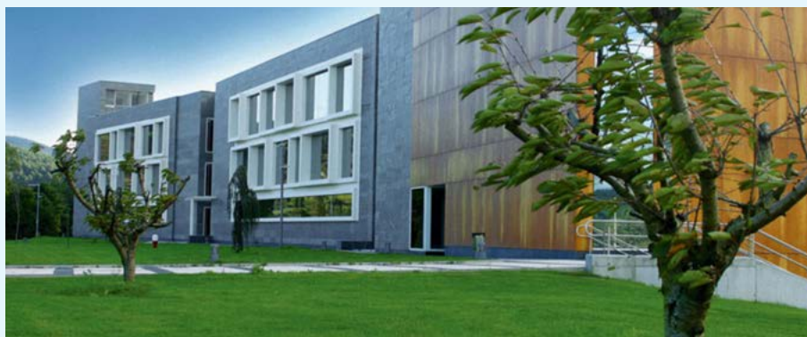
Sede de CIC bioGUNE en el Campus Zamudio/Derio
