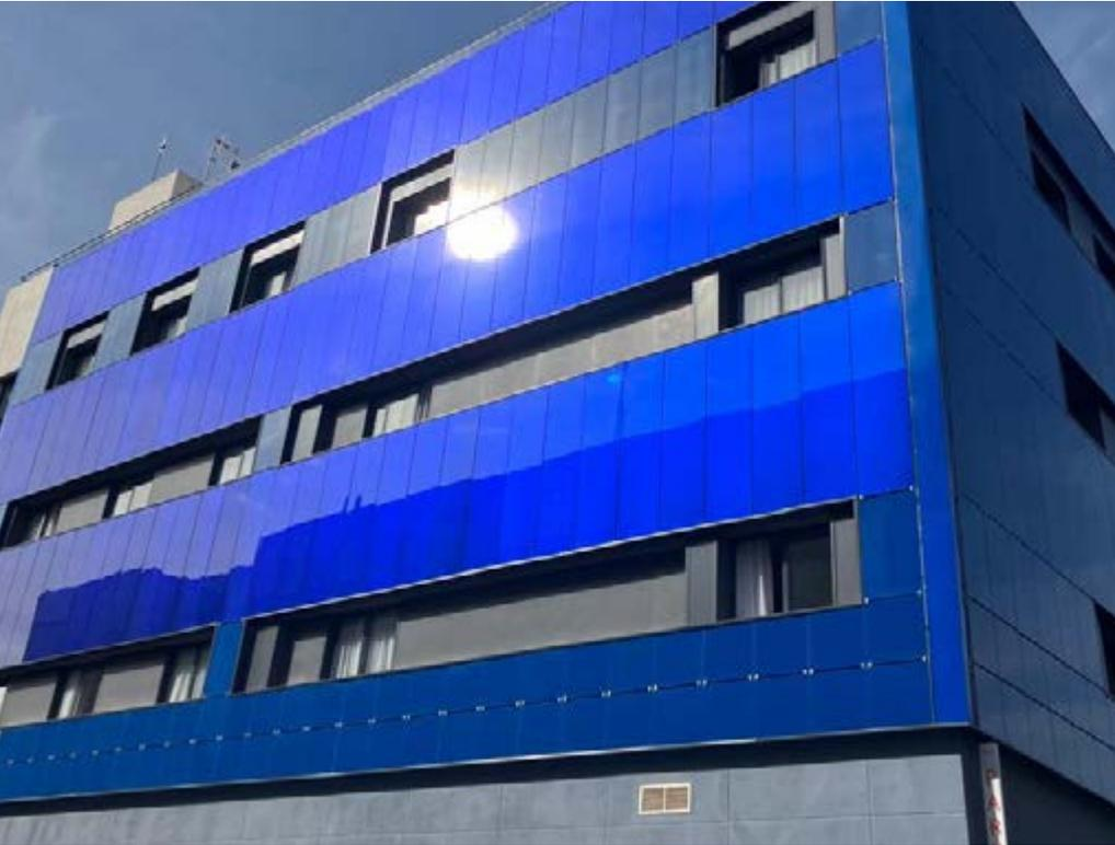
Ejemplo de instalación fotovoltaica en fachada en edificio del PCT Cartuja
