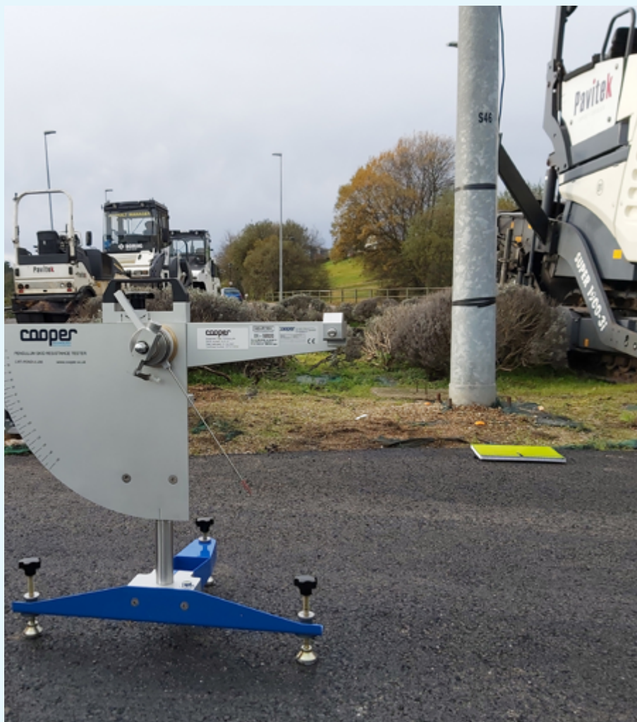
Medición de seguridad y adherencia de pavimento. Fuente: pavitek.es
