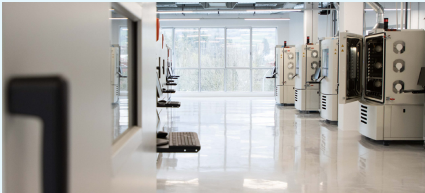
Sala de ensayos de certificación y homologación de baterías en las instalaciones de CIDETEC Energy Storage
