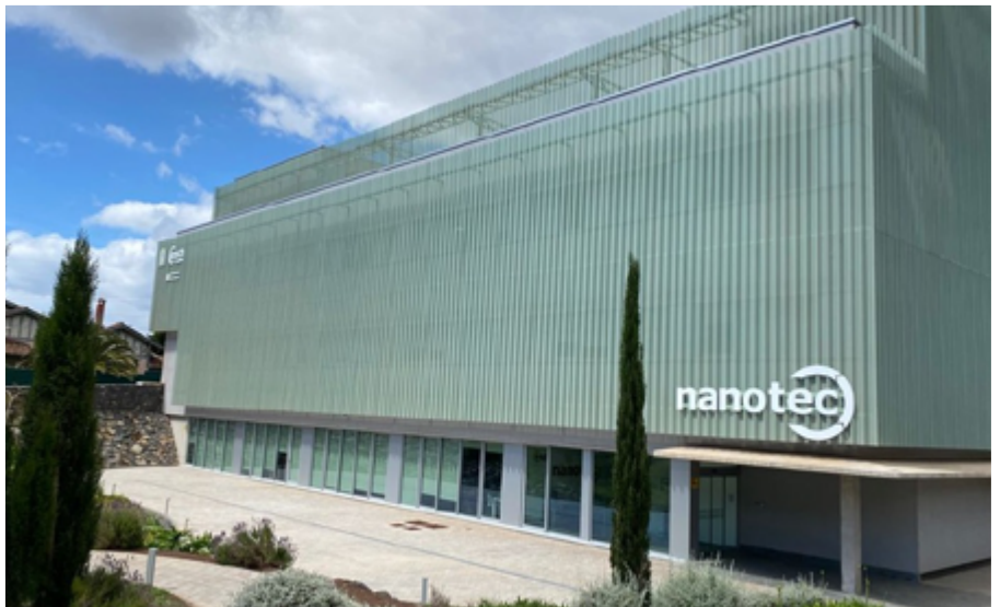
Parque Científico y Tecnológico de Tenerife (edificio NANOTEC)
