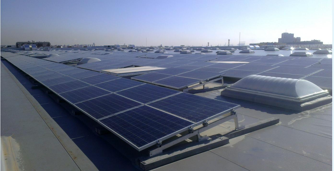
Un reto para la colocación de paneles solares es la existencia de un tipo de cubiertas que, por sus características de construcción, no permiten hacer perforaciones en sus techos. Son cubiertas empleadas en la construcción de grandes centros comerciales, almacenes logísticos o centros de oficinas.
