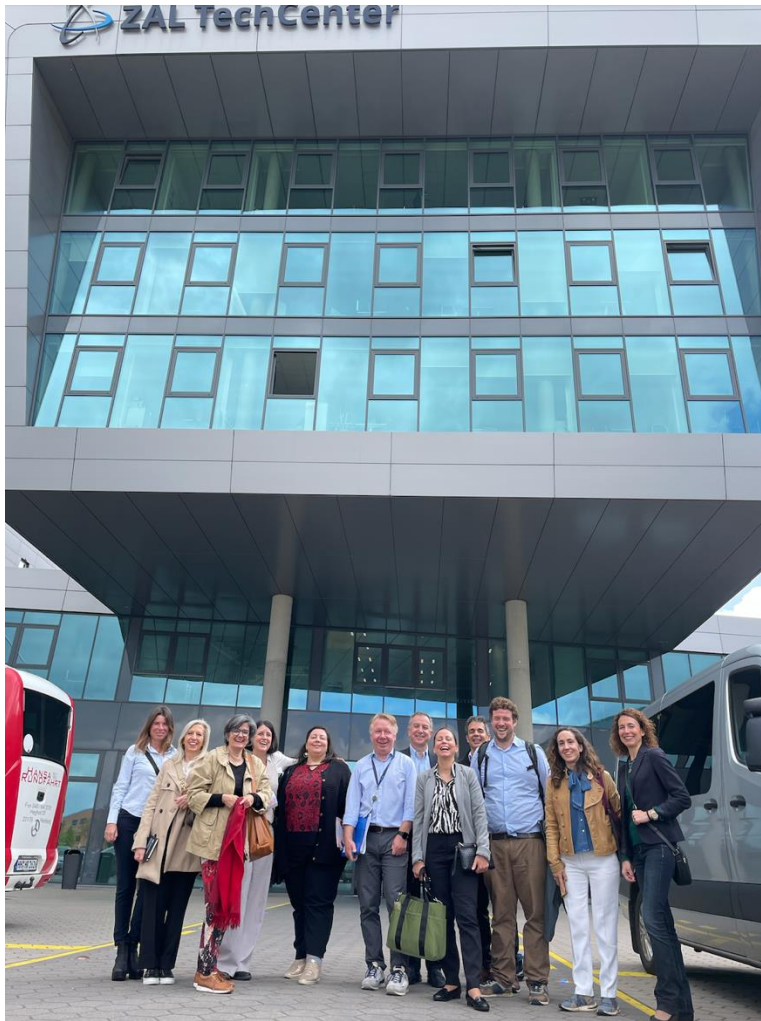
Foto: Delegación española en las instalaciones de ZAL Tech Center
