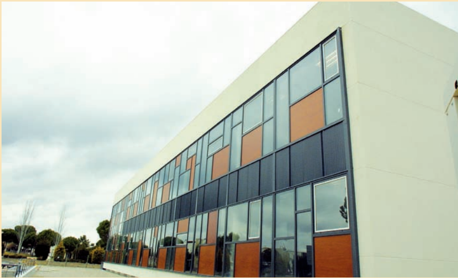
Instalaciones de Incosa en el Parque Tecnológico de Boecillo.
