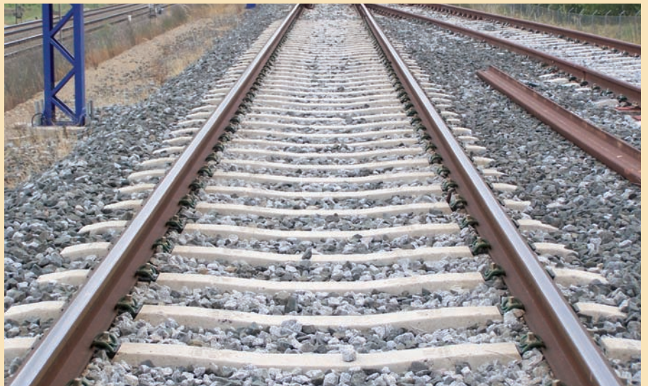
El nuevo hormigón sustituye el metal por fibras poliméricas, con lo que se eliminan las corrientes de electricidad.
