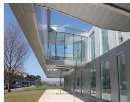
Edificio de servicios científico-tecnológicos del PCTG.
